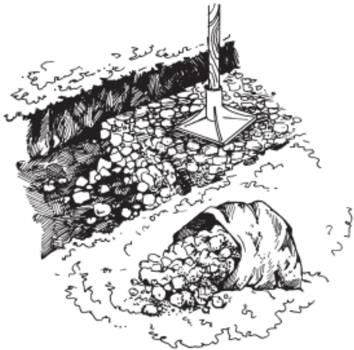
Рис. 13. Утрамбовывание основания
