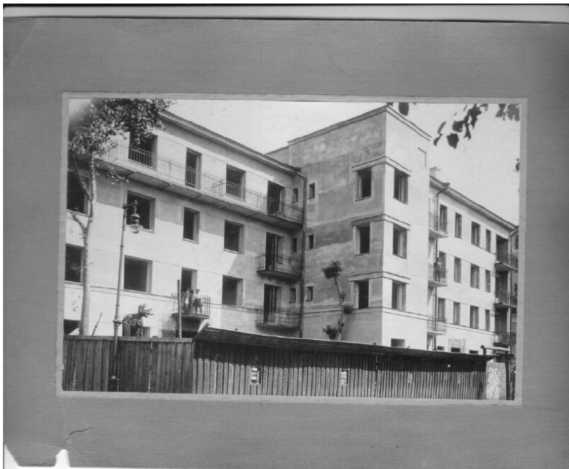
Наш дом на Малой Бронной в процессе строительства. Балкон нашей квартиры – первый слева на третьем этаже дома. Адрес квартиры всегда оставался и остаётся до сих пор неизменным: Москва, Малая Бронная, д. 36, кв. 20.
