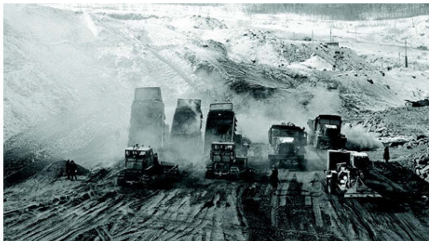
Строительство Вилюйской ГЭС, февраль 1965 г. Мороз под сорок — нормальная рабочая температура.
