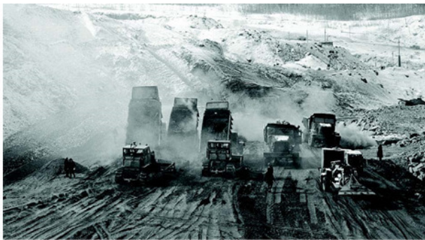
Строительство Вилуйской ГЭС, февраль 1965 г. Мороз под сорок — нормальная рабочая температура.
