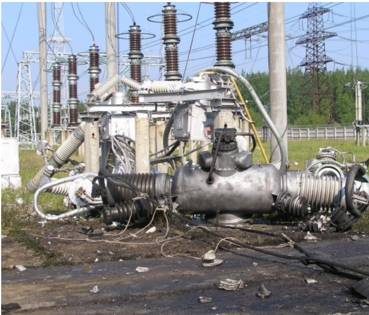
Рис. 1.27. Повреждение воздушного выключателя (а) и разъединителя (б) вблизи ТТ 330 кВ типа ТФРМ-330 (ТРН-330).
