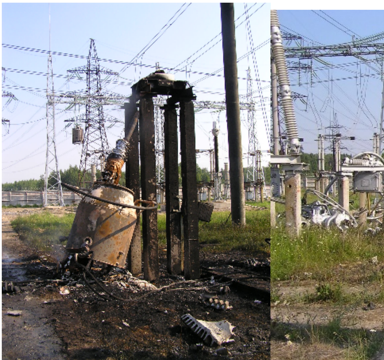
Рис.1.26. Повреждение и пожар на ТТ 330 кВ типа ТФРМ-330 (ТРН-330) фазы "С" на ПС 750 кВ.
