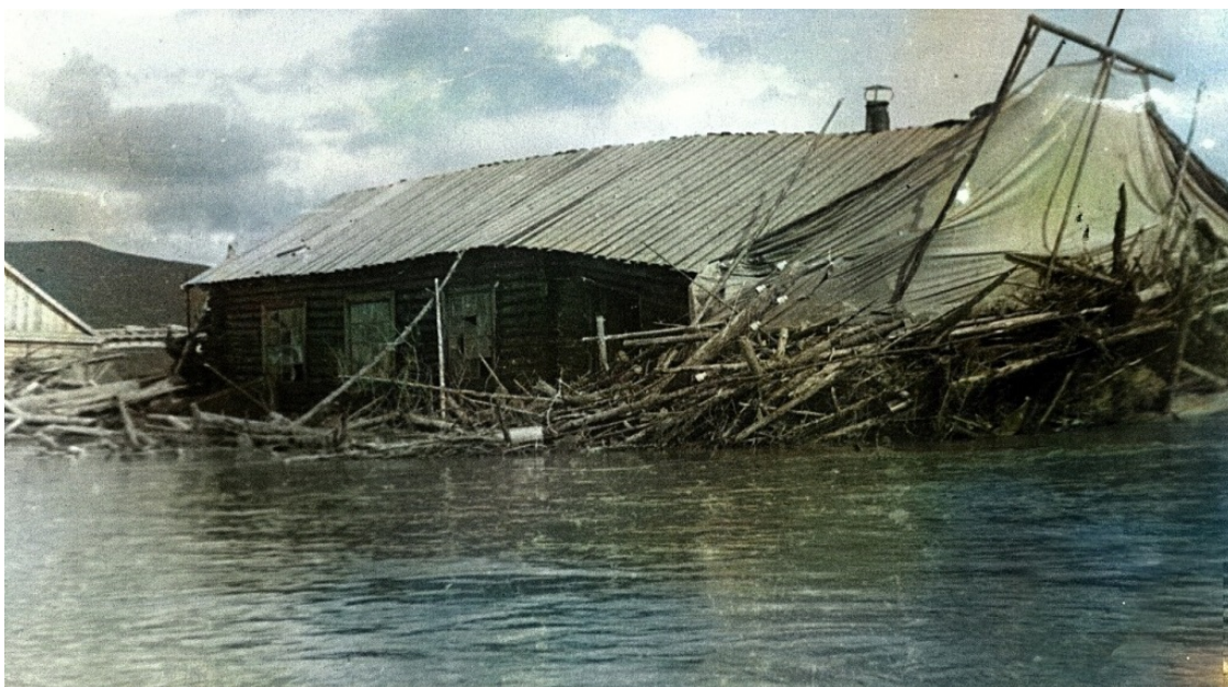
Фото №14 (архив Дорожневца А.Н.). 25 августа 1939 г. – Разрушена столовая красноармейцев и пекарня, снесены жилые палатки.
