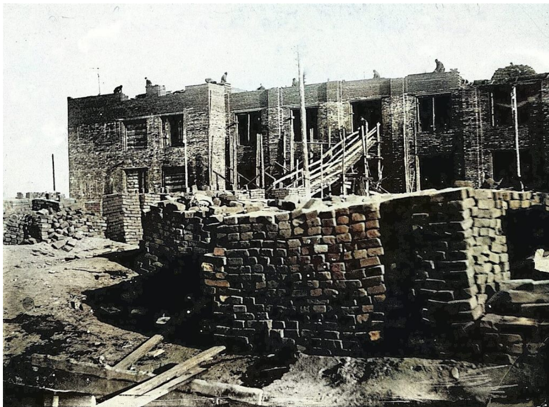
Фото №8 (архив Дорожевца А.Н.). Весна 1939 г. – Идёт строительство казармы 22-го Колымского стрелкового полка ВВ НКВД. Наверное, это самая ранняя фотография будущей Дебинской больницы.
