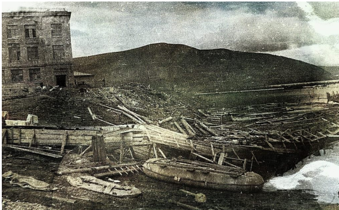
Фото №15 (архив Дорожевца А.Н.). 26 августа 1939 г. – Пик наводнения. Вода подошла к недостроенному зданию казармы. Виден разрушенный водовод в коробе из досок.
