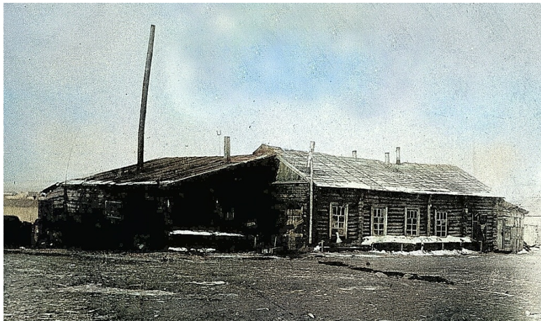
Фото №6в (архив Дорожневца А.Н.). Весна 1938 года. – Пекарня и кочегарка Колымского полка на левом берегу Колымы.
