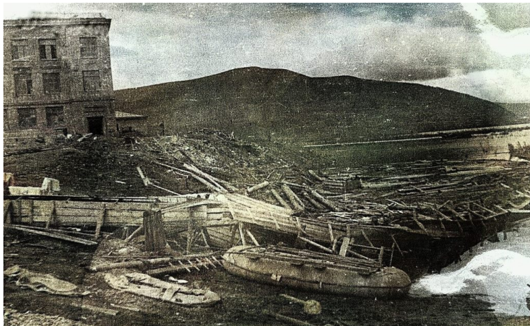
Фото №15 (архив Дорожжевца А.Н.). 26 августа 1939 г. – Пик наводнения. Вода подошла к недостроенному зданию казармы. Виден разрушенный водовод в коробе из досок.
