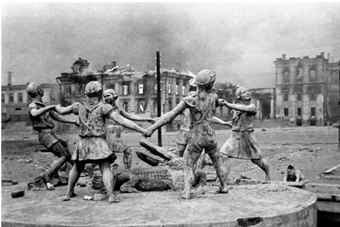
Разрушенный памятник играющим детям на вокзальной площади Сталинграда
