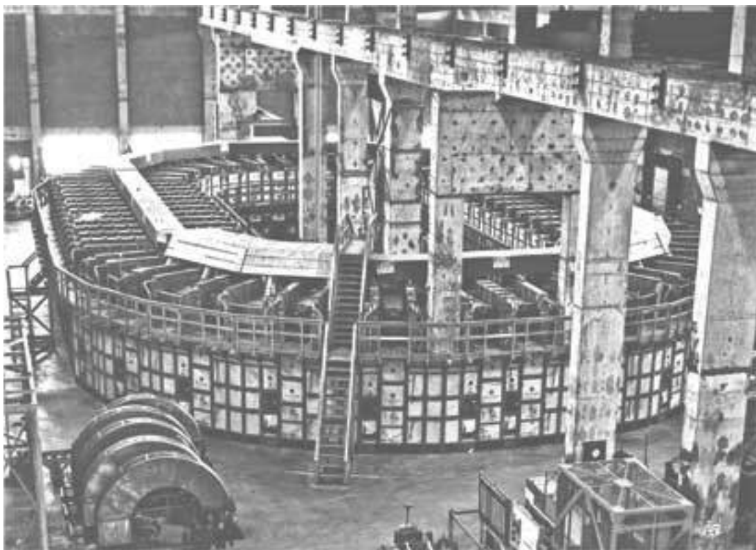
Циклотрон Calutron Лоуренса на заводе Y-12 в Ок-Ридже, штат Тенесси, – на его катушки ушло 14 700 тонн серебра
