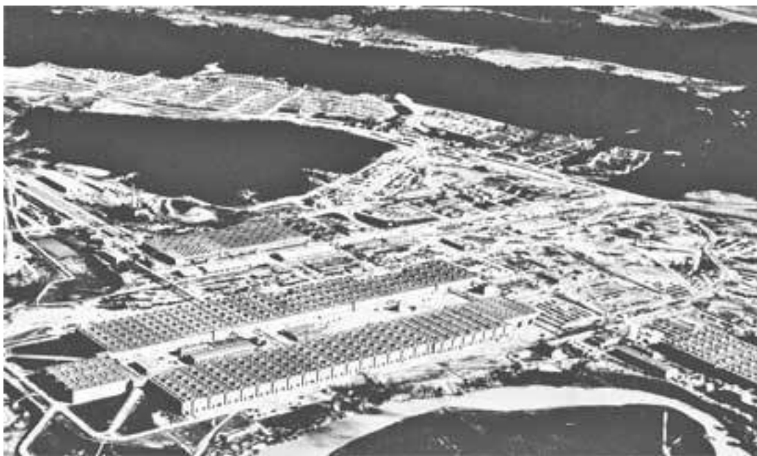
Завод К-25 с корпусами «километровой» длины, в которых на нескольких этажах установлены многие тысячи газодиффузионных машин
