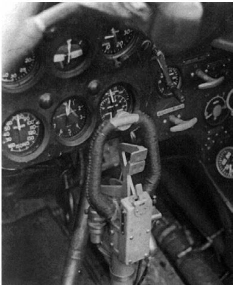
Ручка управления истребителем с «баранкой», внутри которой видны гашетки оружия
