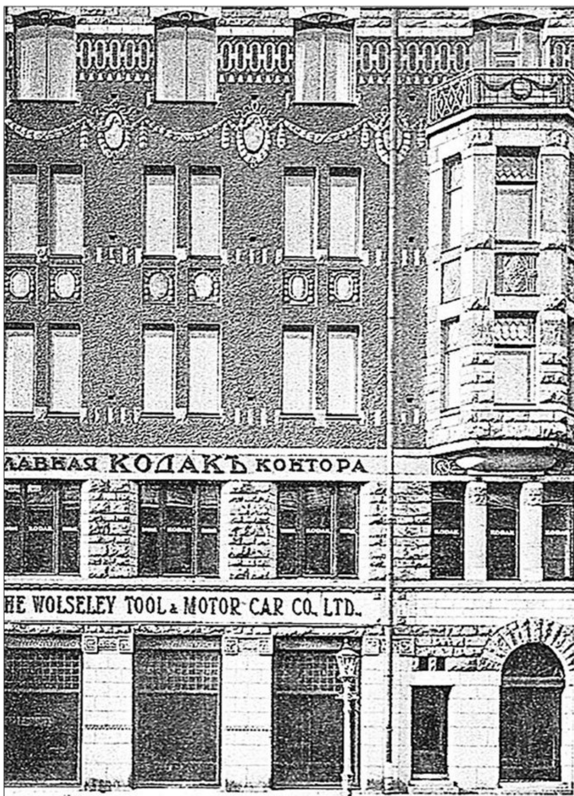
Облицовка грубоколотым и гладкотесанным горшечным камнем элементов фасада доходного дома № 19 на Б. Конюшенной. Фото 1908 г.
