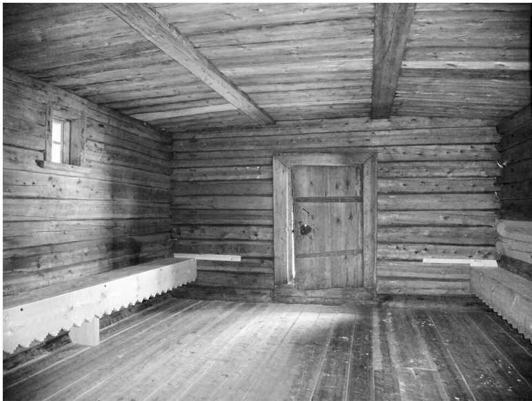
Вспарушенный дощатый потолок и дощатый пол в трапезной
