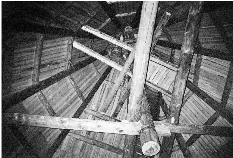
Стропильный шатёр. Видны осевой столб и связевые балки
