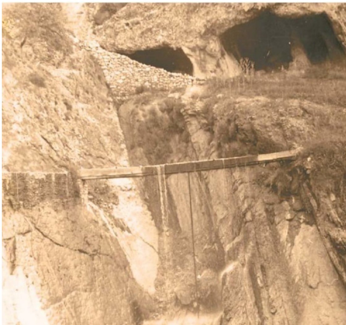
Переброска воды через ущелье. Наверху тоннели-каналы. Гергебиль. 1967 г.
