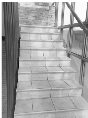
Рис. 1.3. Лестница, облицованная керамогранитом
