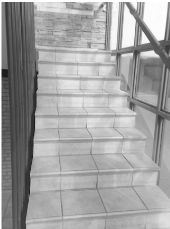
Рис. 1.3. Лестница, облицованная керамогранитом
