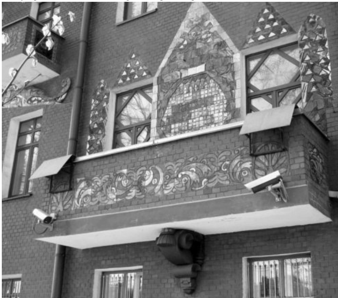
Майолика на фасаде дома Перцова
