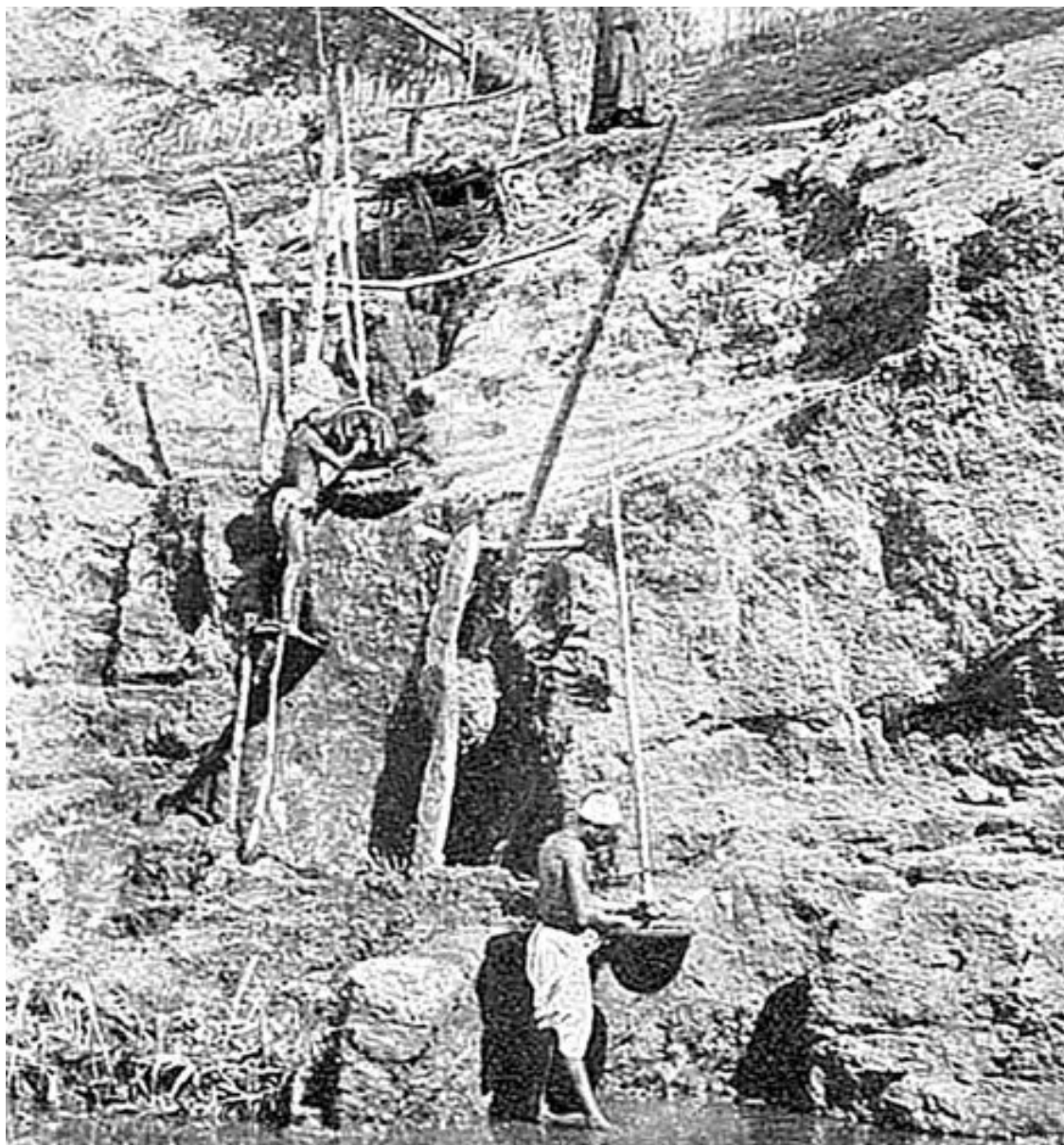
Тройной шадуф. Приспособление, поднимающее нильскую воду для орошения полей
