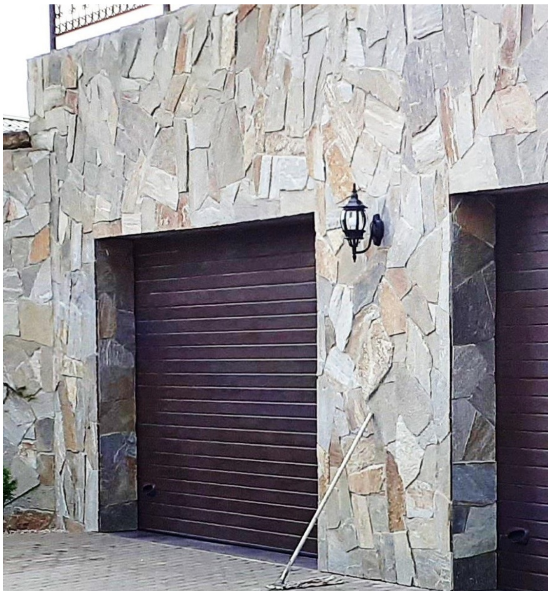
Рис. 3.5. Облицовка стен плитняком.
