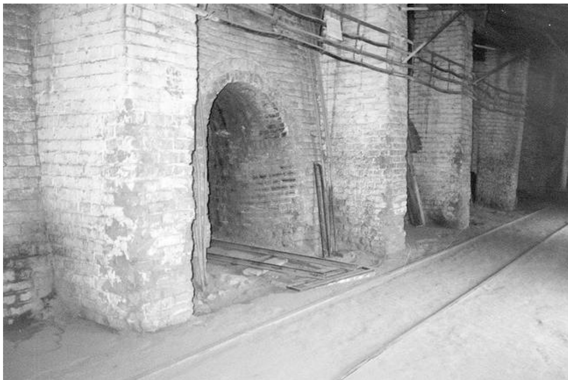
Камеры для обжига кирпича гофманской печи на верхнекотельском заводе, которые установил еще Л.И. Катуар в 1889 г. Фото автора 2000 г.
