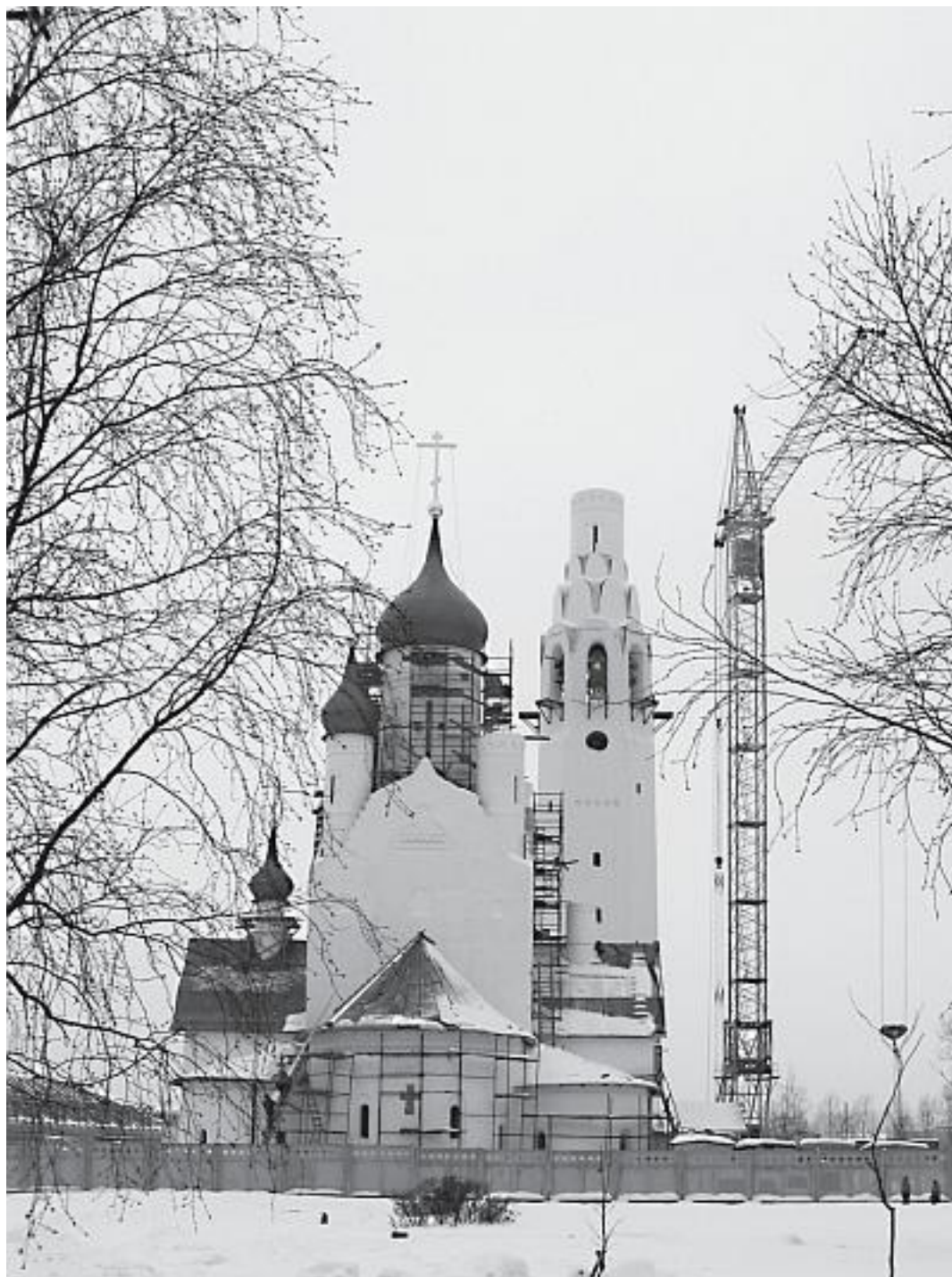
Строительство храма Апостола Петра в парке Строителей. Фото автора, февраль 2010 г.
