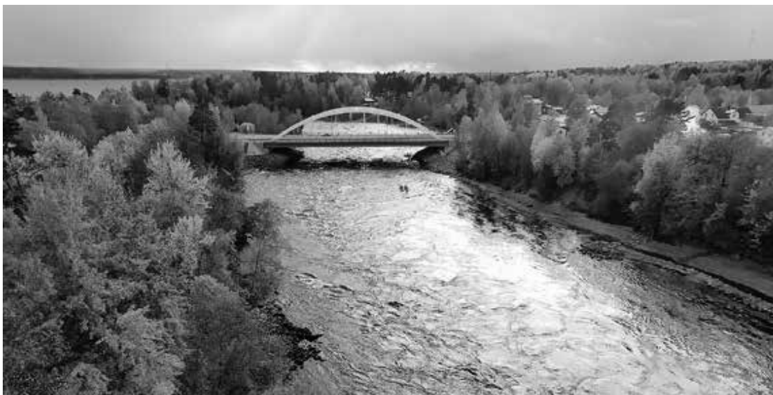
Лосевская протока (вид с арки нового железнодорожного моста)
