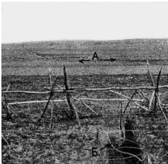
Рис. 1. А – русский окоп, с ясно видимыми даже на фотографии, бойницами, которые – со дна рва Б проектировались на фоне неба. Б – проход из-под бруствера австрийского окопа в сторожевой (снайперовский) ровик. Снято с бруствера австрийского окопа.
