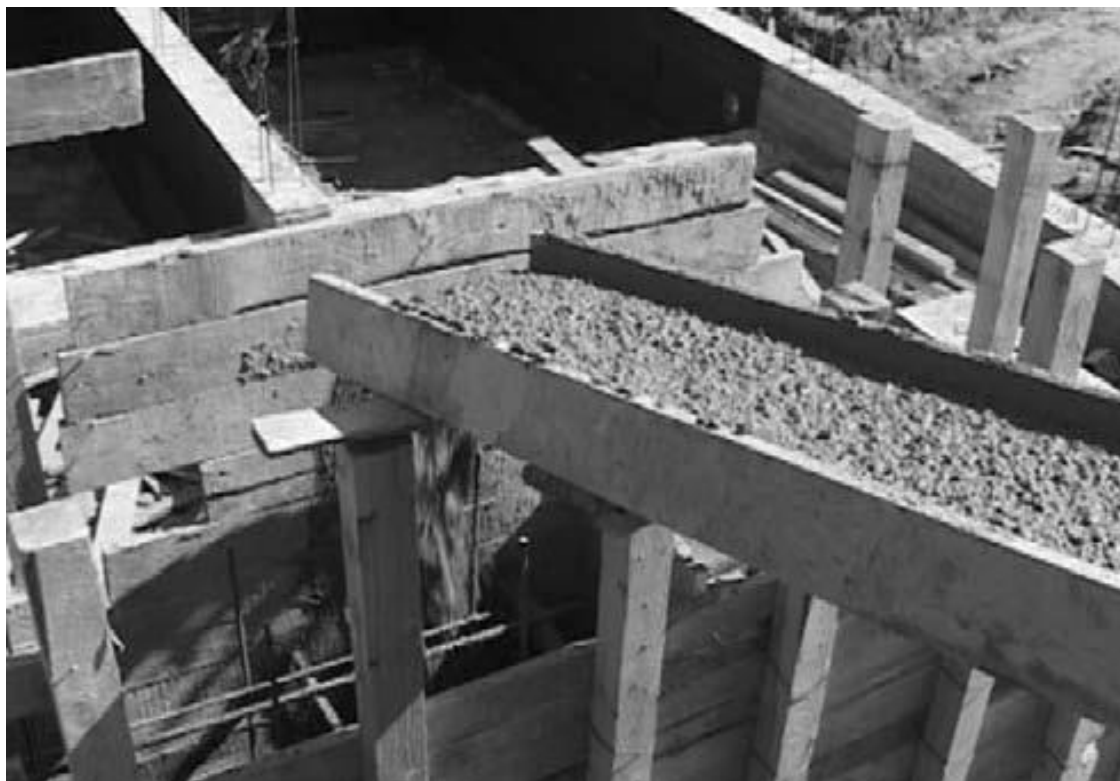
Рис. 2.3. Заливка фундамента с использованием желоба
