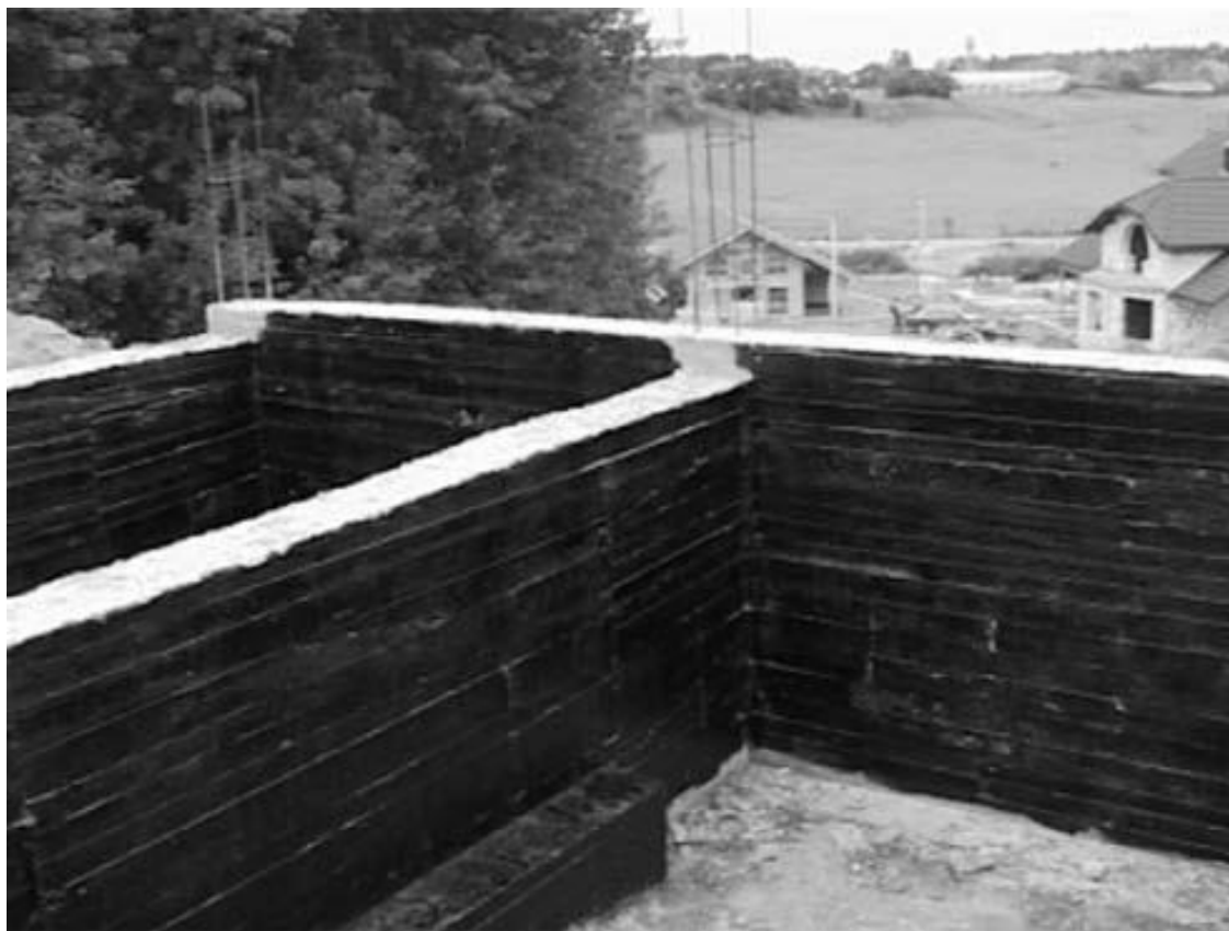
Рис. 2.5. Гидроизоляция ленточного фундамента битумом
