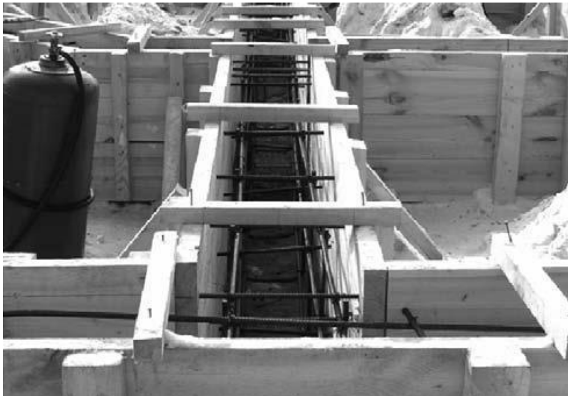
Рис. 2.2. Установка опалубки и арматуры
