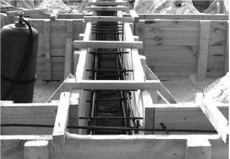
Рис. 2.2. Установка опалубки и арматуры
