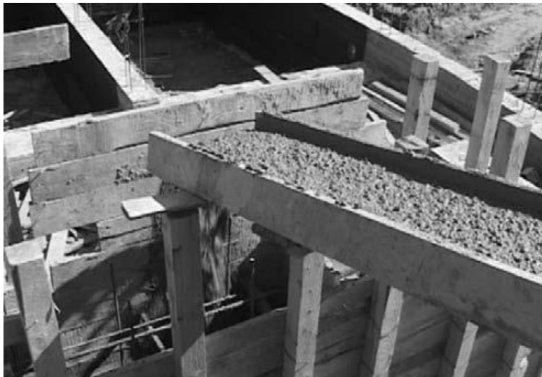
Рис. 2.3. Заливка фундамента с использованием желоба
