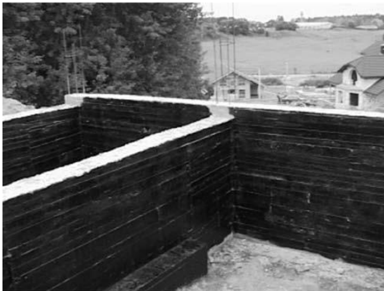
Рис. 2.5. Гидроизоляция ленточного фундамента битумом
