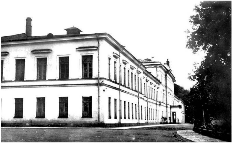
Лесной институт, главный корпус. Фото начала XX века (из фондов ДЦИВ)
