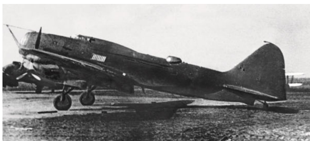
Летающая лаборатория ЦАГИ – ДБ-ЗУПС, предназначавшаяся для исследования управления пограничным слоем крыла
