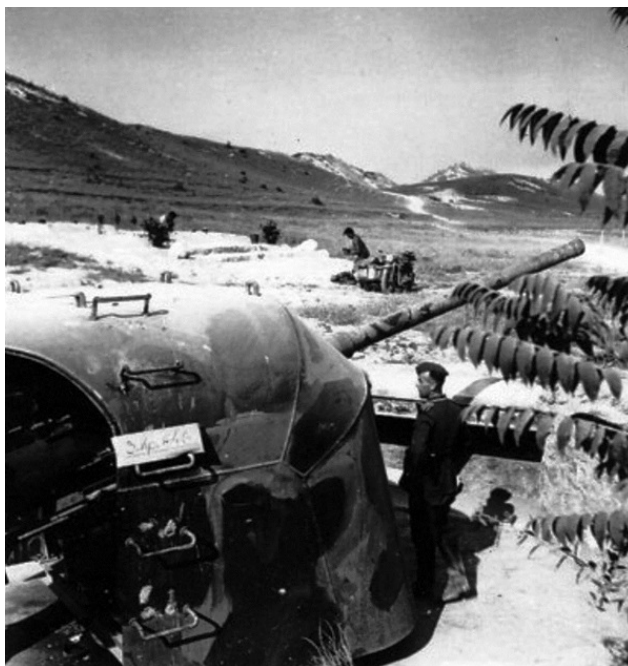
Дот № 55 (открытая оружейная площадка под 100-мм орудие Б-24Б-м)
