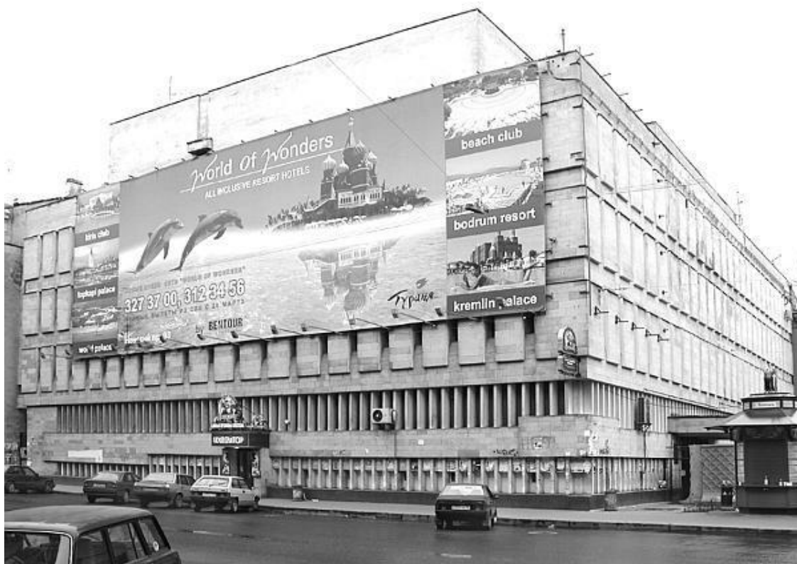
Здание Невских бань
