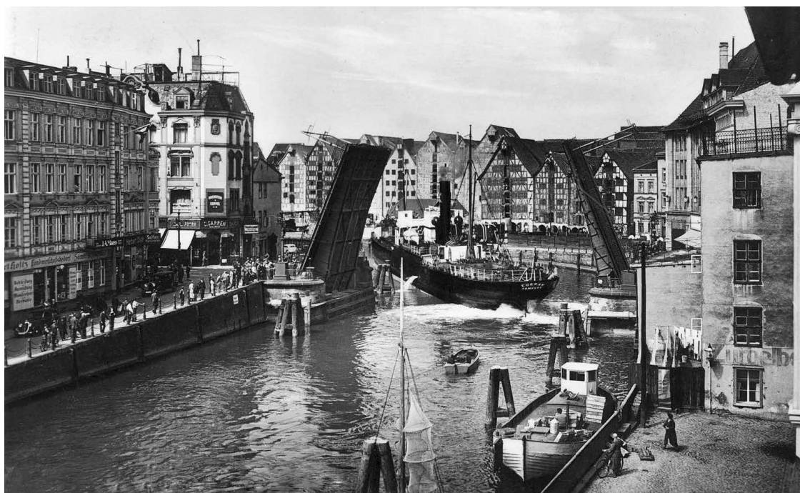
Лавочный мост и старые портовые склады
