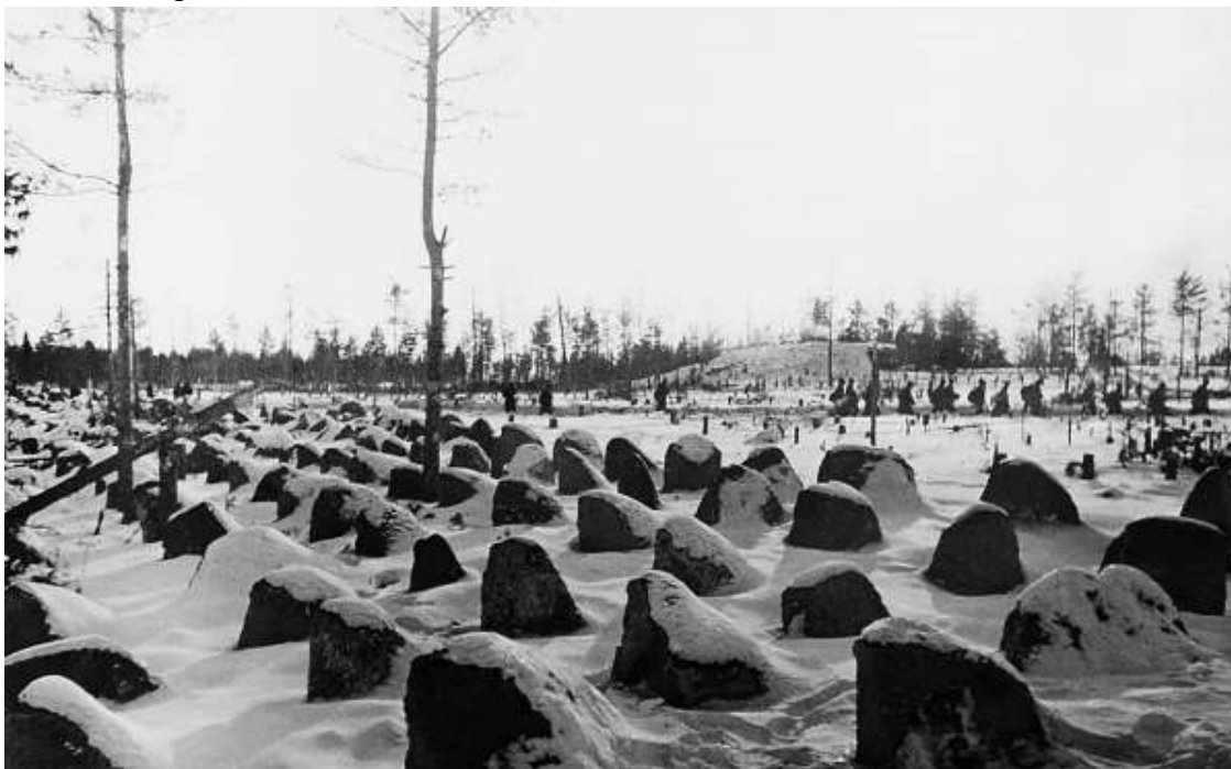
Гранитные надолбы в шесть рядов – типичные противотанковые препятствия «линии Маннергейма» (ЦМВС).
