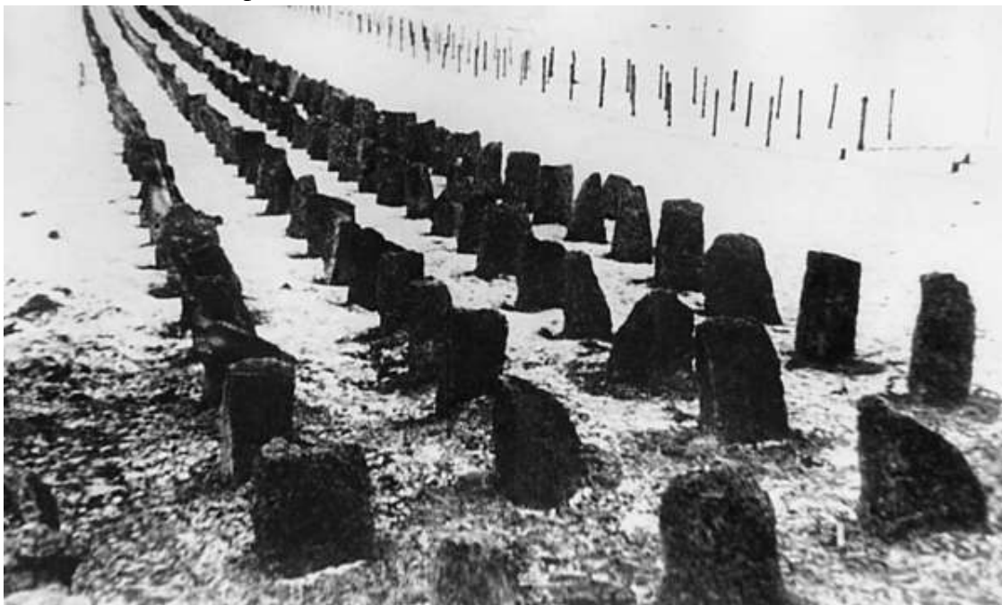
Препятствия «линии Маннергейма» – противотанковые гранитные надолбы в четыре ряда, за ними проволочные заграждения в три ряда (АСКМ).
