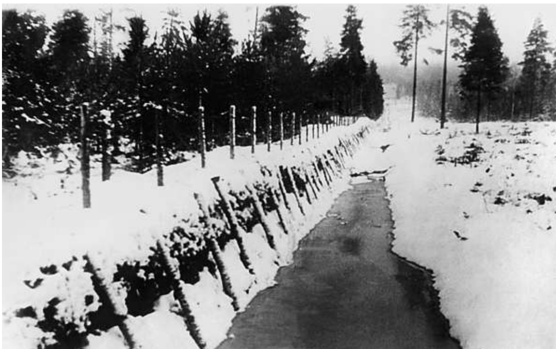
Эскарпированный берег реки на Карельском перешейке. Февраль 1940 года. За эскарпом установлены заграждения из колючей проволоки (АСКМ).
