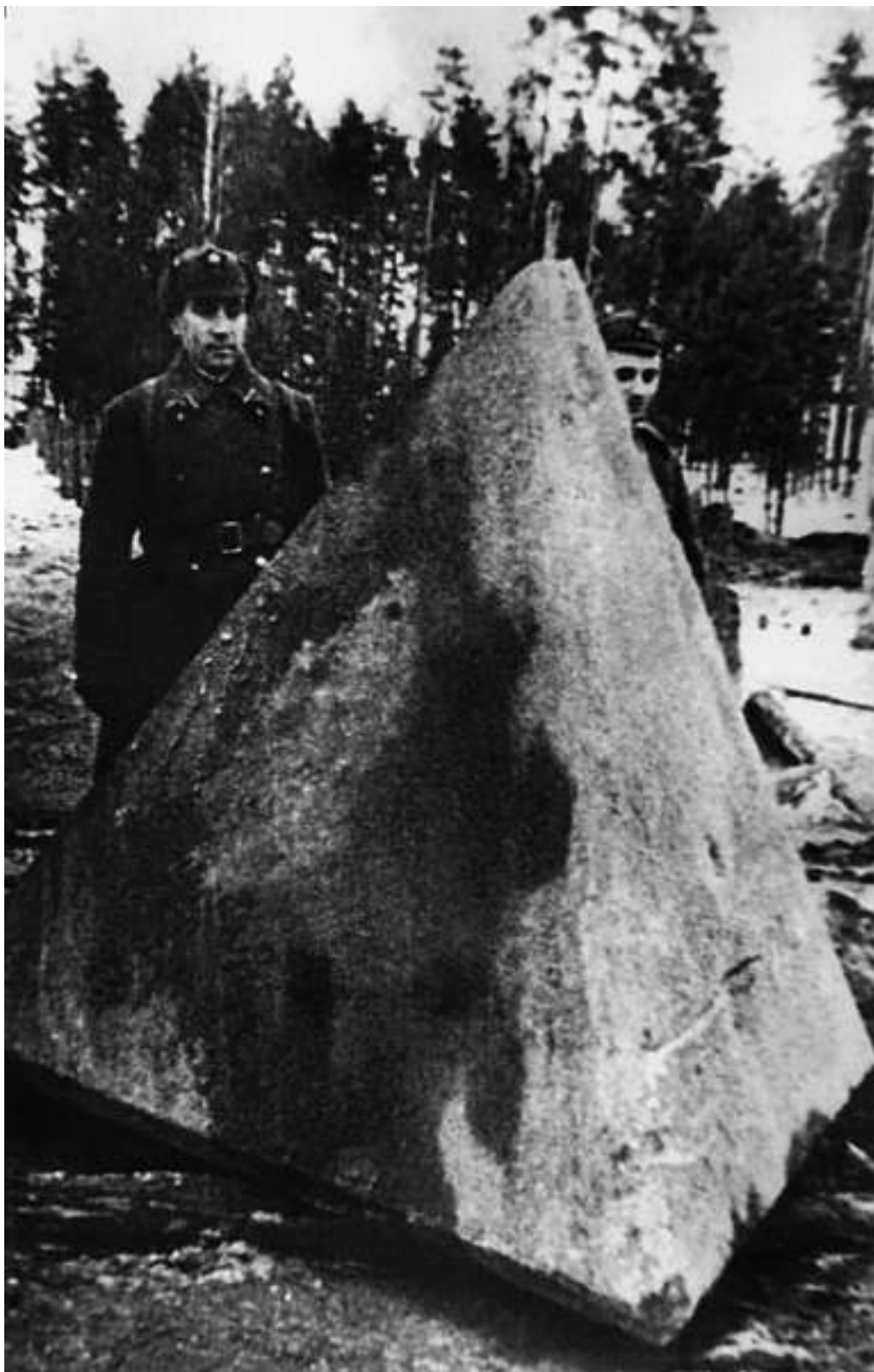
Железобетонная надолба высотой 2 метра. Карельский перешеек, декабрь 1939 года (ЦМВС). Деревянная рогатка на линии проволочных заграждений. Карельский перешеек, январь 1940 года (ЦМВС).
