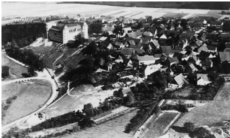
Вид на замок и деревню. Фото 1938 года
