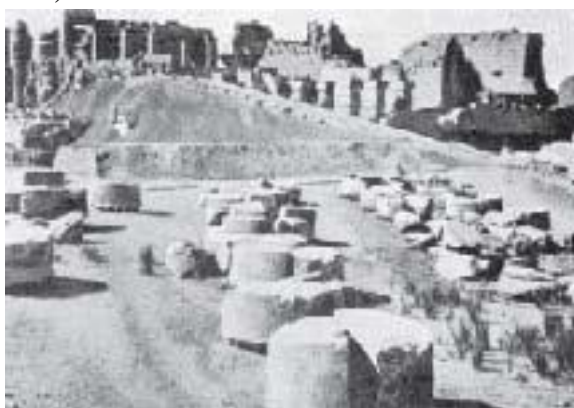
Рис. 7. Карнак. Наклонная насыпь для разборки колонн
