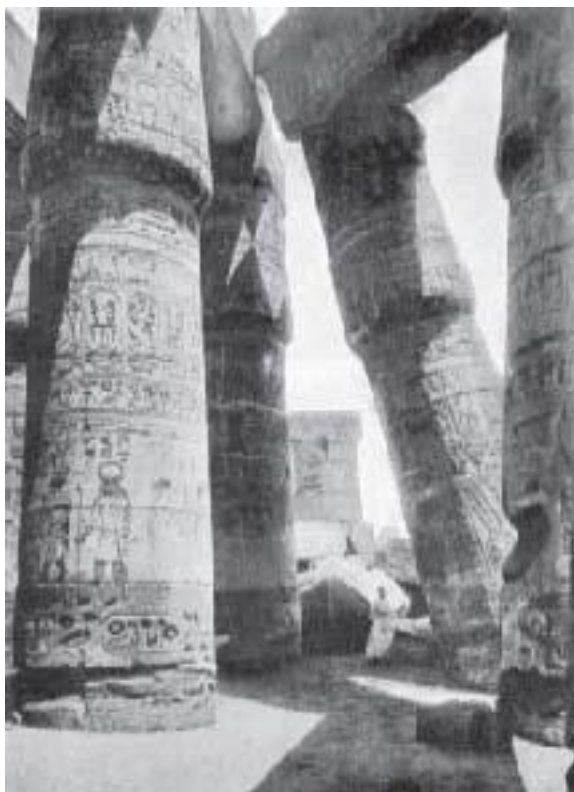
Рис. 1. Карнак. Гипостиль. Наклонившаяся колонна
