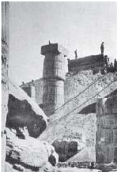
Рис. 6. Карнак. Разборка колонны
