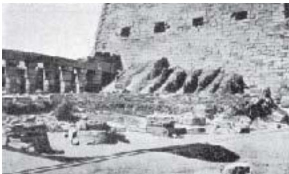
Рис. 5. Карнак. Древняя насыпь, служившая лесами при постройке
