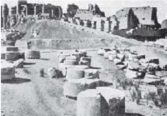
Рис. 7. Карнак. Наклонная насыпь для разборки колонн
