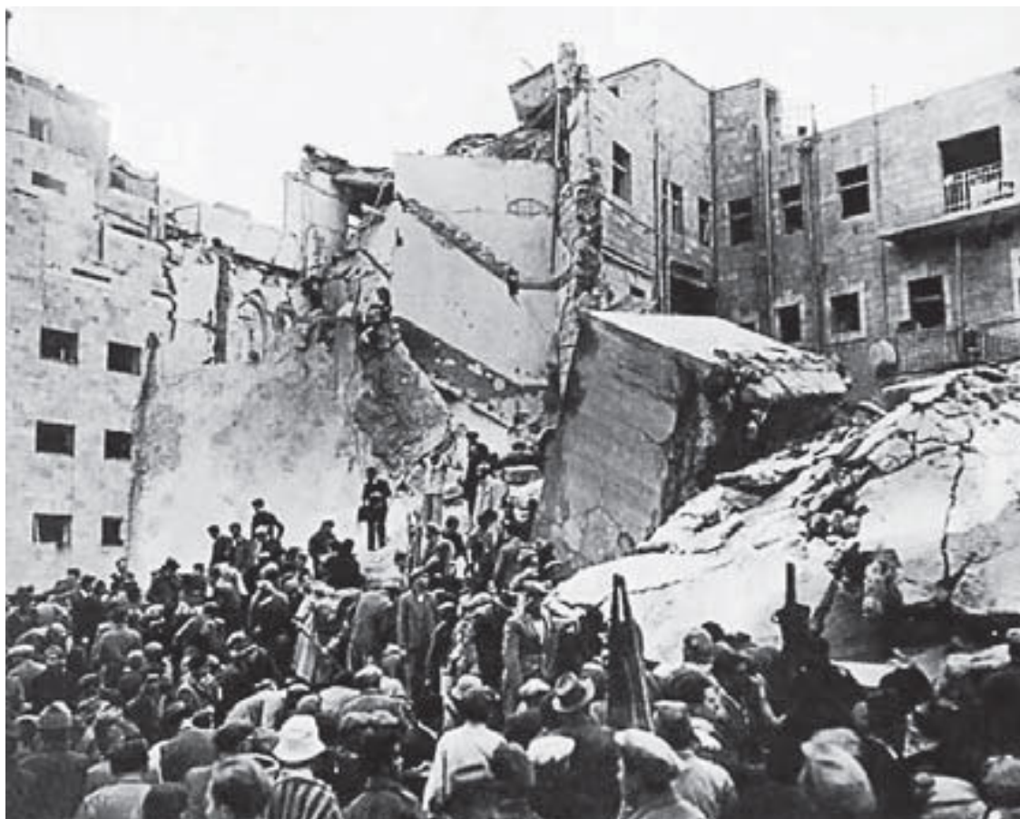
Иерусалим, ул. Яффо. Июнь 1948. Разрушенный дом от прямого попадания крупнокалиберного снаряда
