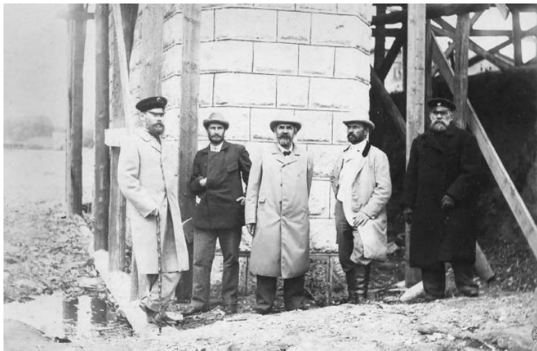
На строительстве железнодорожного моста через реку. Л. И. Немировский – второй справа. Конец XIX в.
