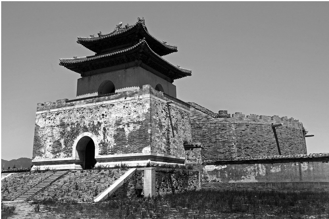
Рис. 11. Круглая стена, окружающая погребальный курган в Восточной долине царей, и пристроенная к ней башня – вход в гробницу. Фотография 2010 года.
