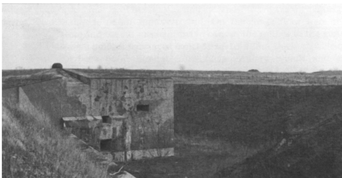
Блок IV – типичный капонир, целиком размещенный в противотанковом рву
