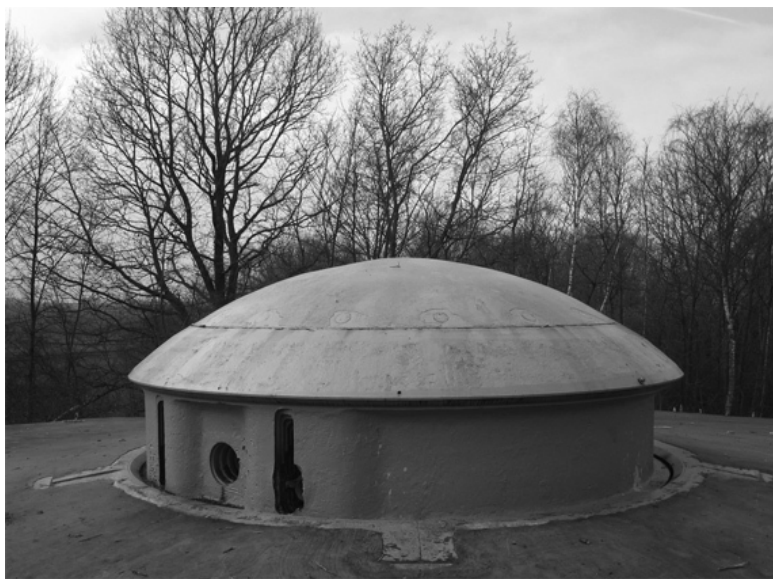
Спаренная 75-мм скрывающаяся башня
