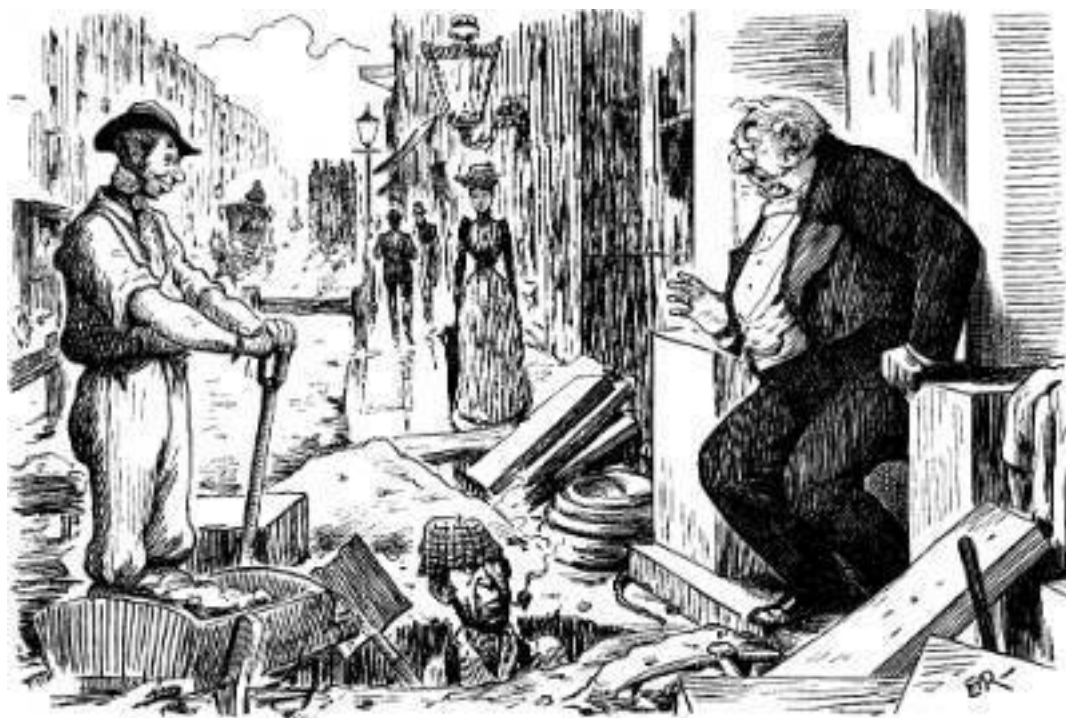
Земляные работы по прокладке электрического кабеля. Рисунок из журнала "Punch". 1890
