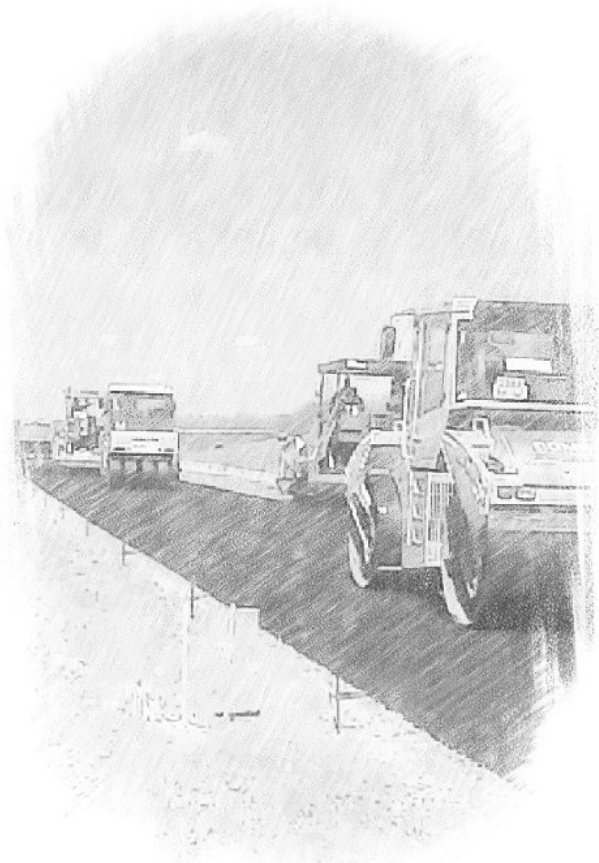
Укладка и уплотнение асфальта под струну летом в Краснодаре
