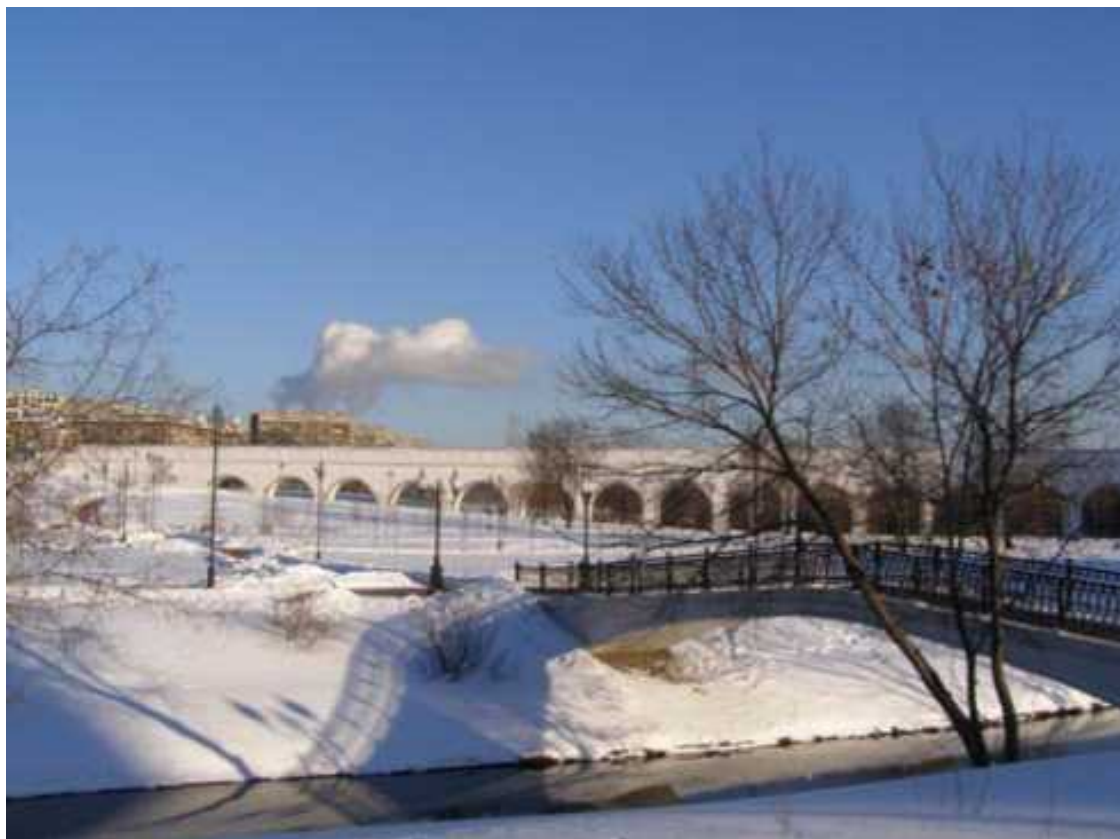
Ростокинский виадук московского водопровода из Яузских болот
