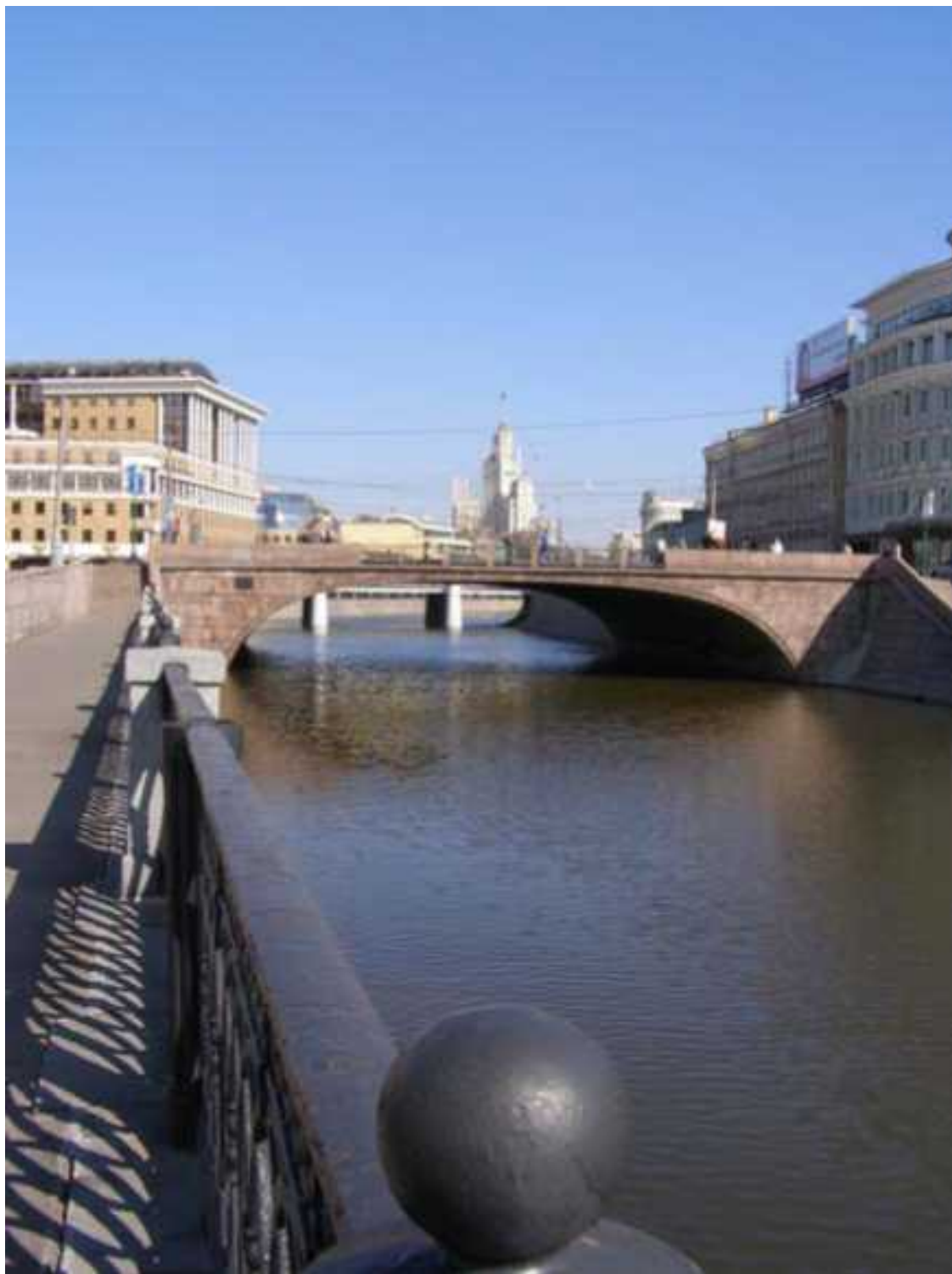
Обводной канал. Чугунный мост
